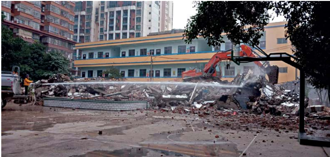
高山塘小学拆旧建新项目施工现场
