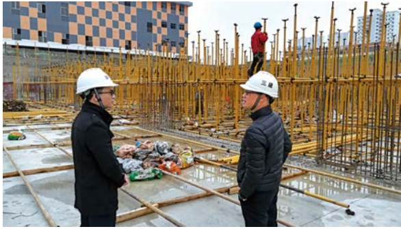
现场安全检查
